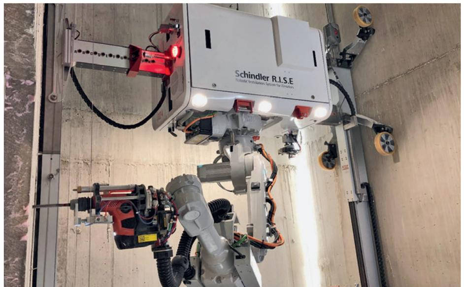
Mit dem robotergestützten Aufzugsinstallationsystem Schindler R.I.S.E wird die Liftmontage automatisiert.
