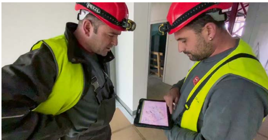
Auf der Baustelle beschleunigen digitale Pläne die Prozesse vor allem bei Rückfragen und auftretenden Kollisionen. (2020, Basel)
