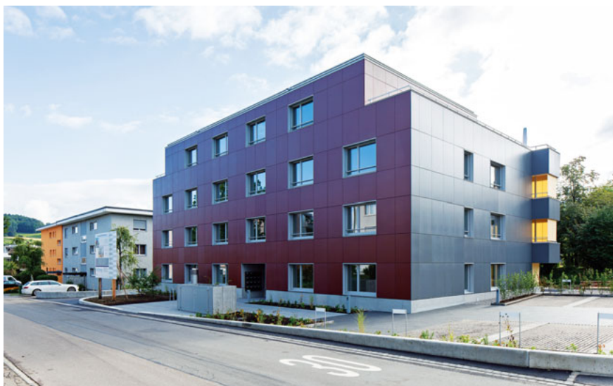
Das Plusenergiehaus an der Seewadelstrasse in Affoltern a. Albis mit Solarfassade: Terracotta-Rot auf der Strassenseite gegen Nordwesten, Grau an den übrigen Fassadenseiten.
