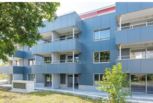
Die Balkone gegen Südosten – auch mit PV-Modulen ausgestattet.
