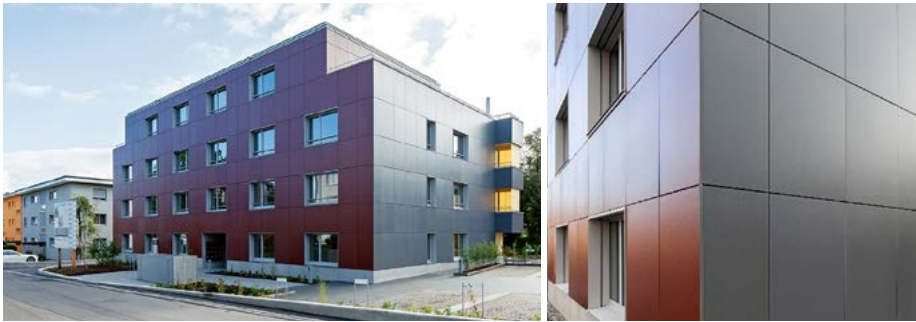
Das Plusenergiehaus an der Seewadelstrasse in Affoltern am Albis mit Solarfassade: Terracotta-Rot auf der Strassenseite gegen Nordwesten, Grau an den übrigen Fassadenseiten (Farbwechsel an der Gebäudeecke).
