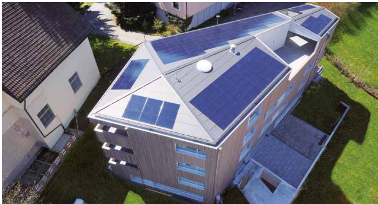
Wohn- und Geschäftshaus, Kriens. Dachabschluss und Solarenergienutzung in einem.
