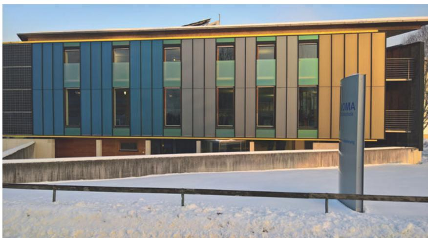
Fassade mit thermischen Sonnenkollektoren, die mit Kromatix-Solarglas ausgerüstet sind.
