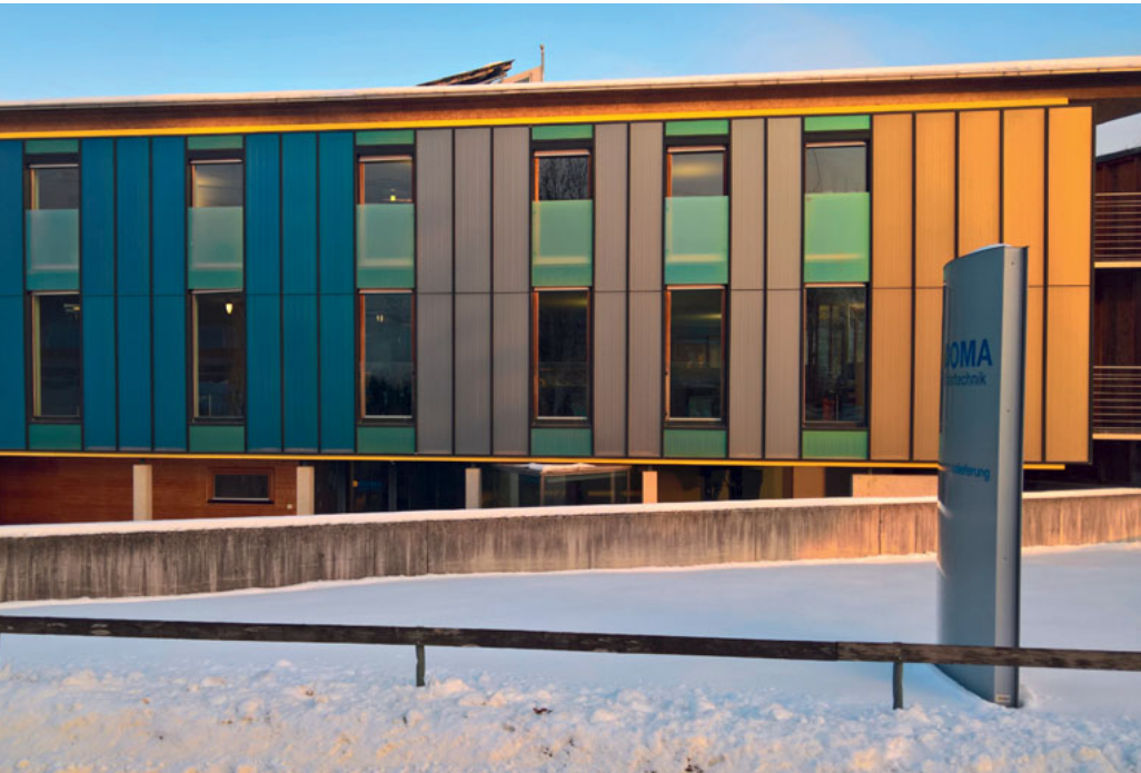
Fassade mit thermischen Sonnenkollektoren, die mit Kromatix-Solarglas ausgerüstet sind.
